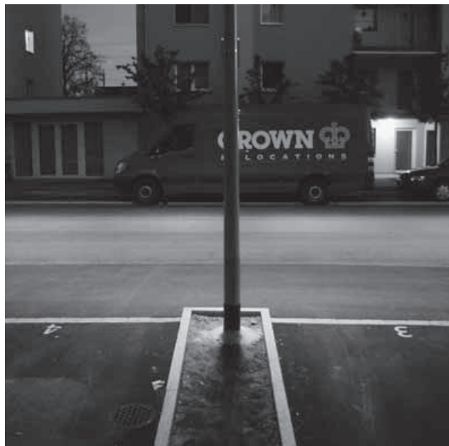
Abb. 4 Gute Abschirmung bei moderner Strassenbeleuchtung (2012). Neue Warmweiss-LED Leuchten kommen schon nahe an das Optimum aus Sicht von Dark-Sky Switzerland. Eine typische Strasse mit Wohnanteil in Wallisellen zeigt, dass die angrenzenden Häuser mit Schlafräumen unbehelligt bleiben, während der Strassenraum, die Trottoirs und Parkplätze genügend hell und sicher sind.
