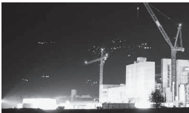
Abb. 5a und 5b. Der Dialog macht den Unterschied. Vorstandsmitglied Stefano Klett hat mit den Betreibern einer Baustelle beim Ausbau der Kehrichtverbrennungsanlage Bellinzona gesprochen. Es ist nur ein einzelner Handgriff nötig, um den Neigungswinkel einer Flutlichtleuchte zu verstellen. Der Unterschied ist augenfällig.
