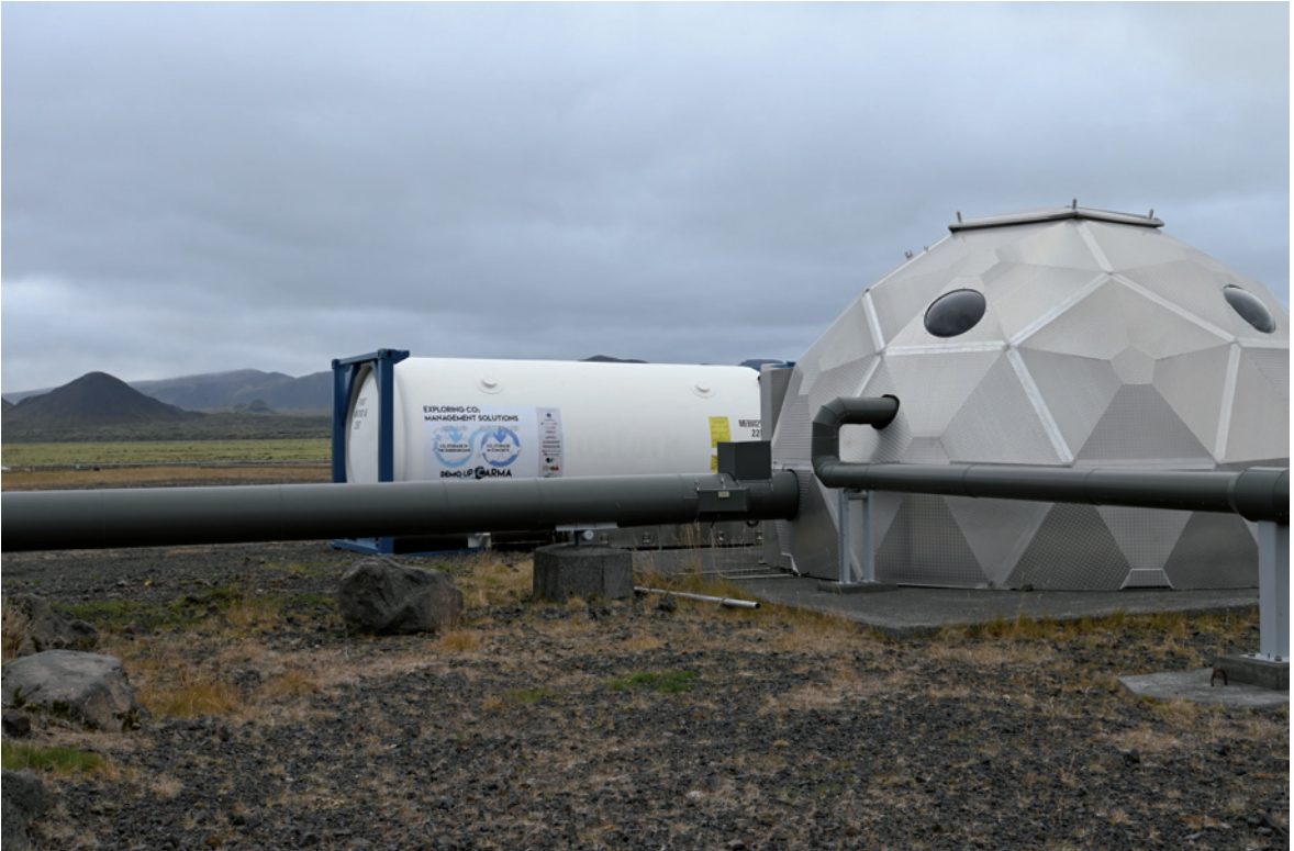
In einer Versuchsanlage in Island wurde das abgeschiedene CO 2 aus der Schweiz in Meerwasser gelöst und danach in eine reaktive Gesteinsformation aus Basalt zur dauerhaften mineralischen Speicherung injiziert. Sowohl die Reaktion des isländischen Untergrunds auf die Injektion als auch der Mineralisierungsprozess wurden laufend überwacht. Island wurde als Speicherort ausgewählt, weil das Land sowohl über günstige geologische Eigenschaften verfügt als auch über das Wissen und die Erfahrung, CO 2 unterirdisch zu speichern. (Foto: DemoUpCARMA / ETH Zürich)
