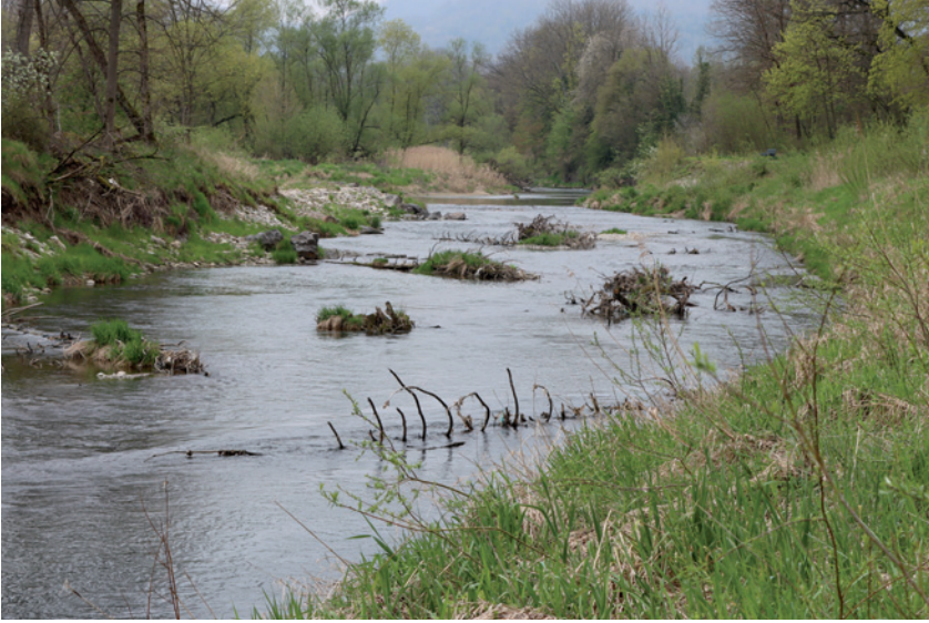
Abb. 2: Revitalisierte Flussstrecke mit «Raubäulen» und Wurzelstöcken zur Uferstabilisierung und Schaffung von Lebensraumstrukturen an der Aare bei Olten. (Foto: Florian Altermatt)
